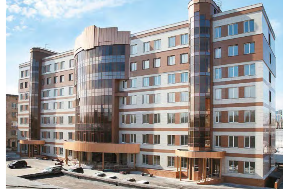
Новый корпус НГТУ
