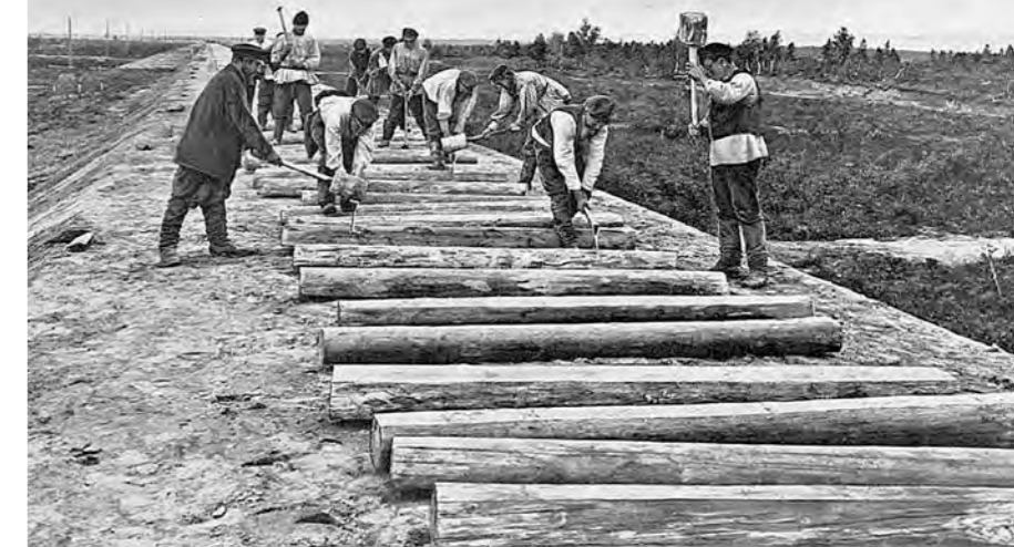
Укладка шпал на Транссибирской железнодорожной магистрали, 1896 год
