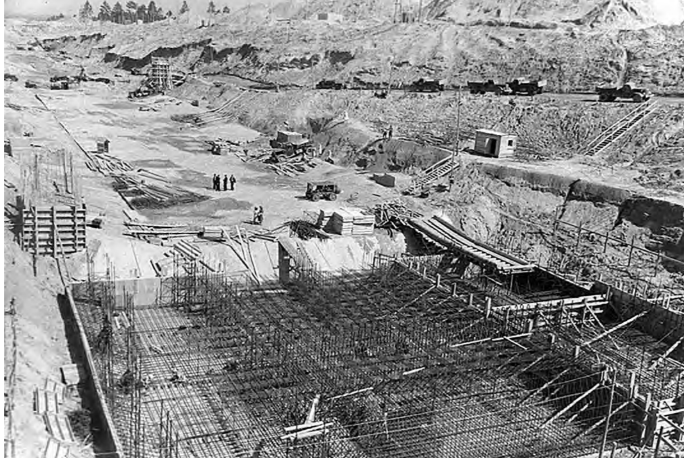
Укладка первого бетона в основание ГЭС
