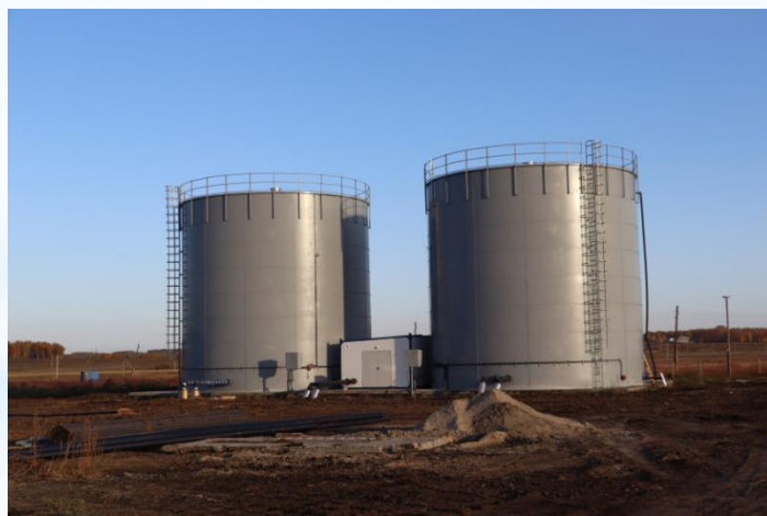
Строительная площадку комплекса объекта по водоочистки и водоподготовки в р.п.Коченево.
