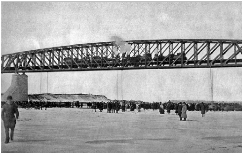
13. Испытания моста с нагрузкой в четыре паровоза, март 1897 г.
